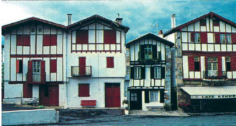
Les façades à colombages des maisons mitoyennes d'Aïnhoa (photo MSM SA)
