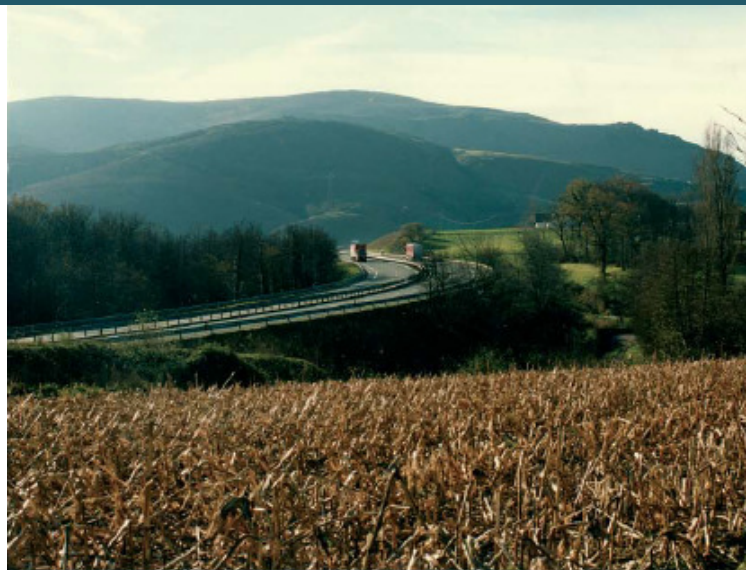
Passage de l'autoroute dans les collines
