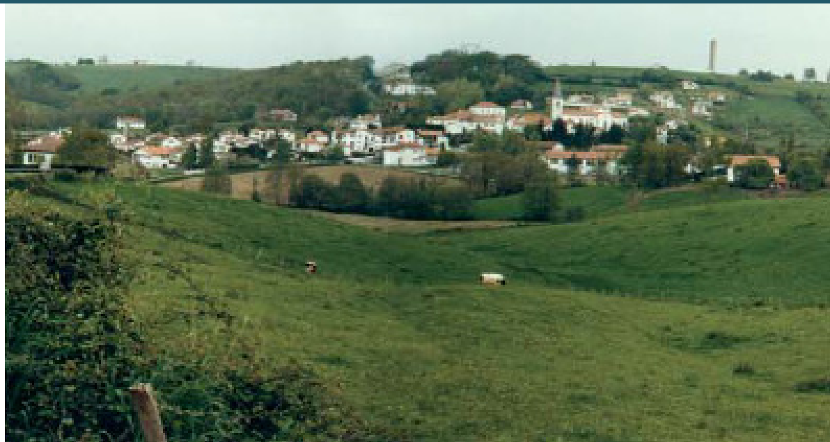
Depuis la D936, vue sur le village groupé de Briscous, établi sur la crête d'une colline basse (alt. 50 m)
